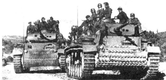
Рз III Ausf L Африка. 1942 г. Хорошо видна дополнительная броневая защита маски пушки
